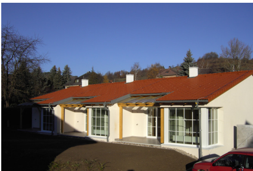
Die Seniorenwohnanlage Pöggstall wurde bereits im November 2006 bezogen. Am 12. Mai 2007 um 11 Uhr findet die feierliche Eröffnung statt.
